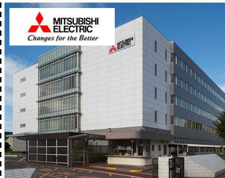
製作所 名古屋製作所
